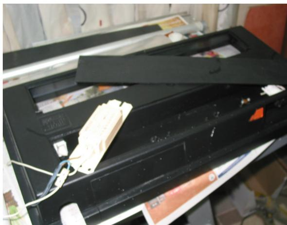
Die Abdeckung wird von der kompletten alten Elektrik befreit ...
