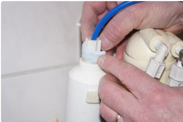
Gut durchgeknetet kann diese Masse an die Schadensstelle aufgebracht werden und diese ohne Luftschlüsse nach dem Aushärten steinhart umhüllen.
